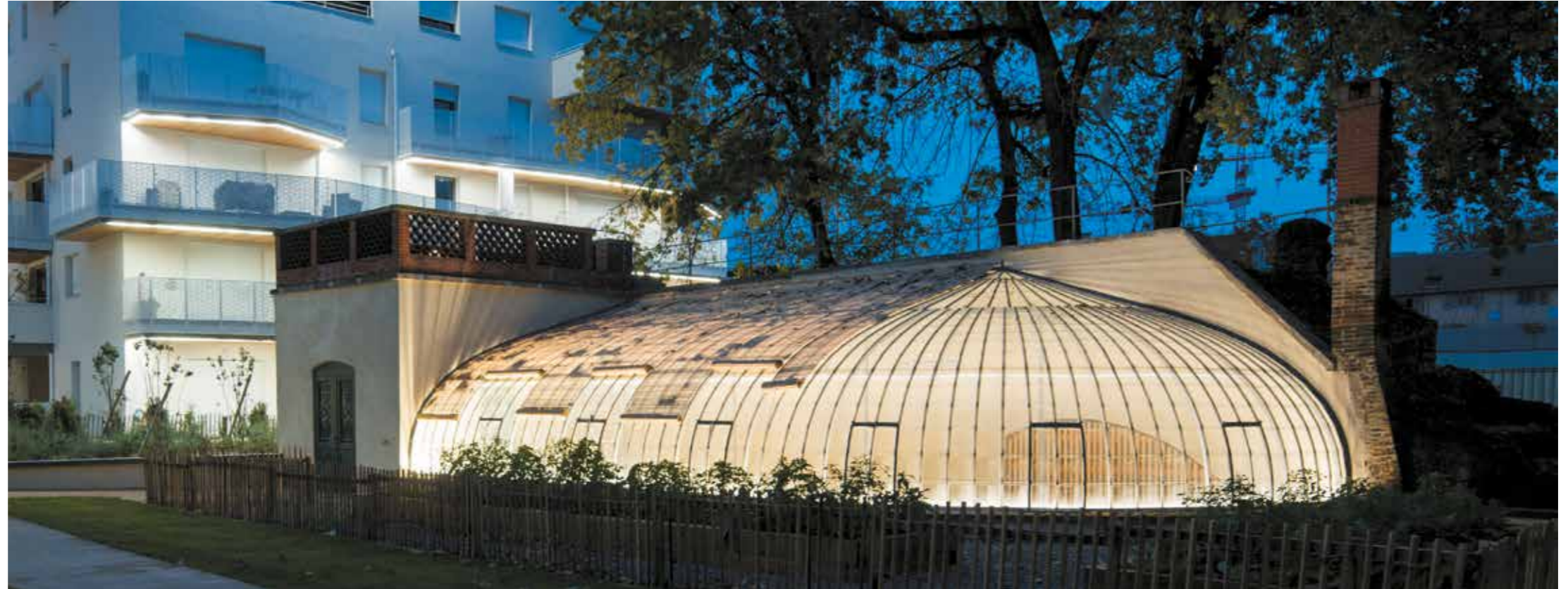
Serre réhabilitée (Oasis Parc, Lyon 8)
