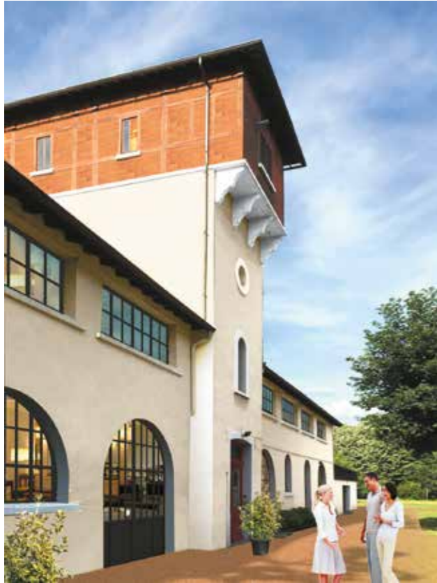
Toit aménagé en nichoir à chiroptères (Oasis Parc, Lyon 8)
