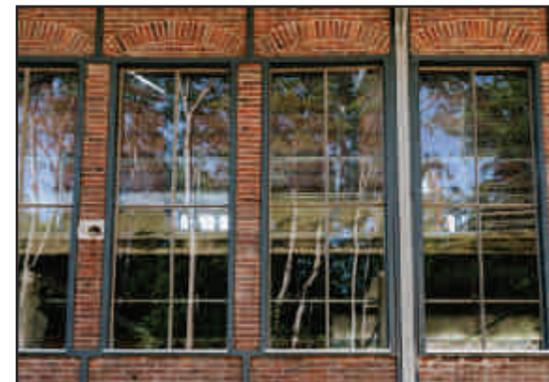
**Façade latérale en cours de rénovation, après repose des briques et restauration des menuiseries.**
