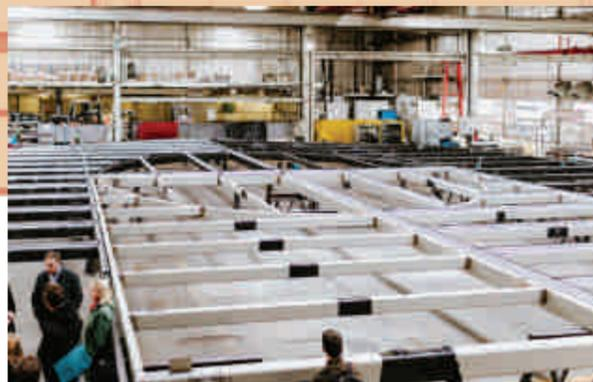
**Pré-montage en usine de la charpente métallique, qui sera posée en façade principale.**
