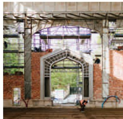
**Retrait des briques une à une pour les remettre en état, avant de les reposer en façade.**
