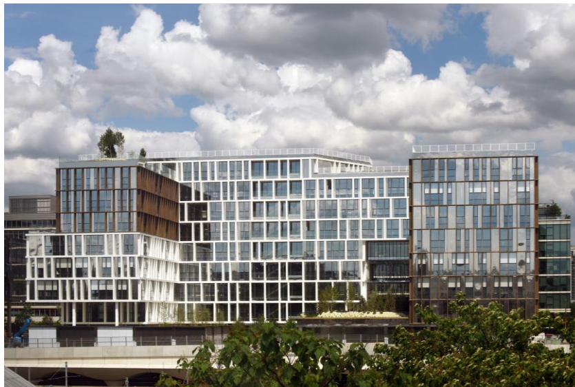
Elements , situé sur l'avenue Pierre Mendès France dans le 13 ème arrondissement de Paris.
